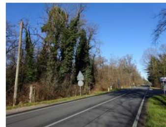
COMUNE DI SOMMA LOMBARDO (VA) Messa in sicurezza della strada statale 336
