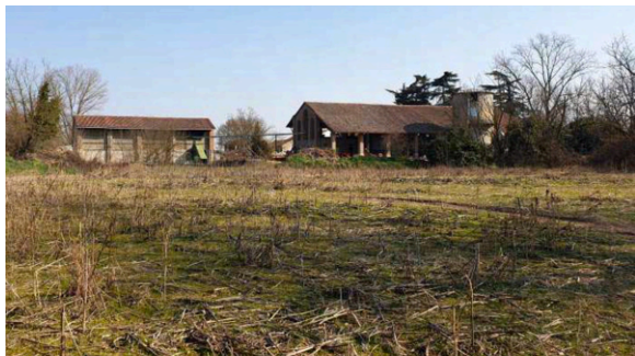
EDIFICIO INTERESSANTO INTERVENTO STATO DI FATTO
