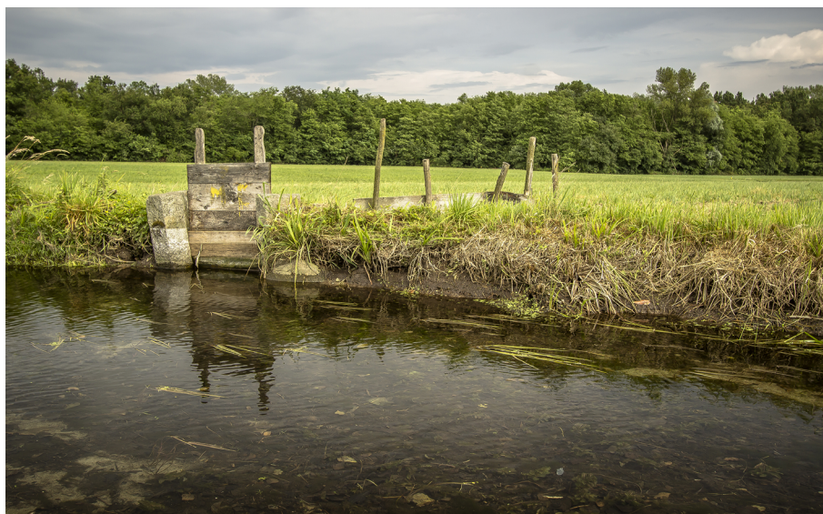
Fig. 89 - Typical wooden lock, Marcita di Bernate - Photo M. Tessaro
