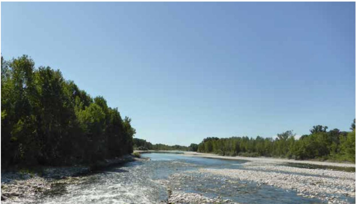
Lo sbarramento in testa al Canale Treccione, a differenza delle due filarole precedentemente trattate, è classificabile come struttura fissa. Altra rilevante differenza rispetto alle filarole è data dal regime idraulico di monte: le filarole sono soggette alle fluttuazioni di portata che defluisce lungo il Ticino, mentre a monte dello sbarramento del Treccione transita una portata che, in quanto derivata, è meno soggetta ad escursioni.
