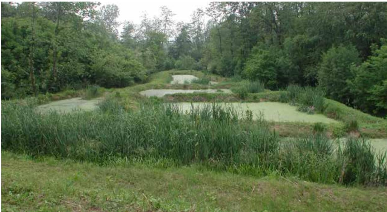
Anche l'inquinamento di tipo diffuso veicolato dalla rete idrografica minore (rogge e fossi di scolo agricoli), oppure proveniente dal dilavamento superficiale, può essere ridotto attraverso la realizzazione di ecosistemi filtro, mediante la sistemazione, il modellamento e la diversificazione degli alvei dei canali irrigui, oppure mediante la realizzazione di bacini naturaliformi colonizzati da vegetazione acquatica.
