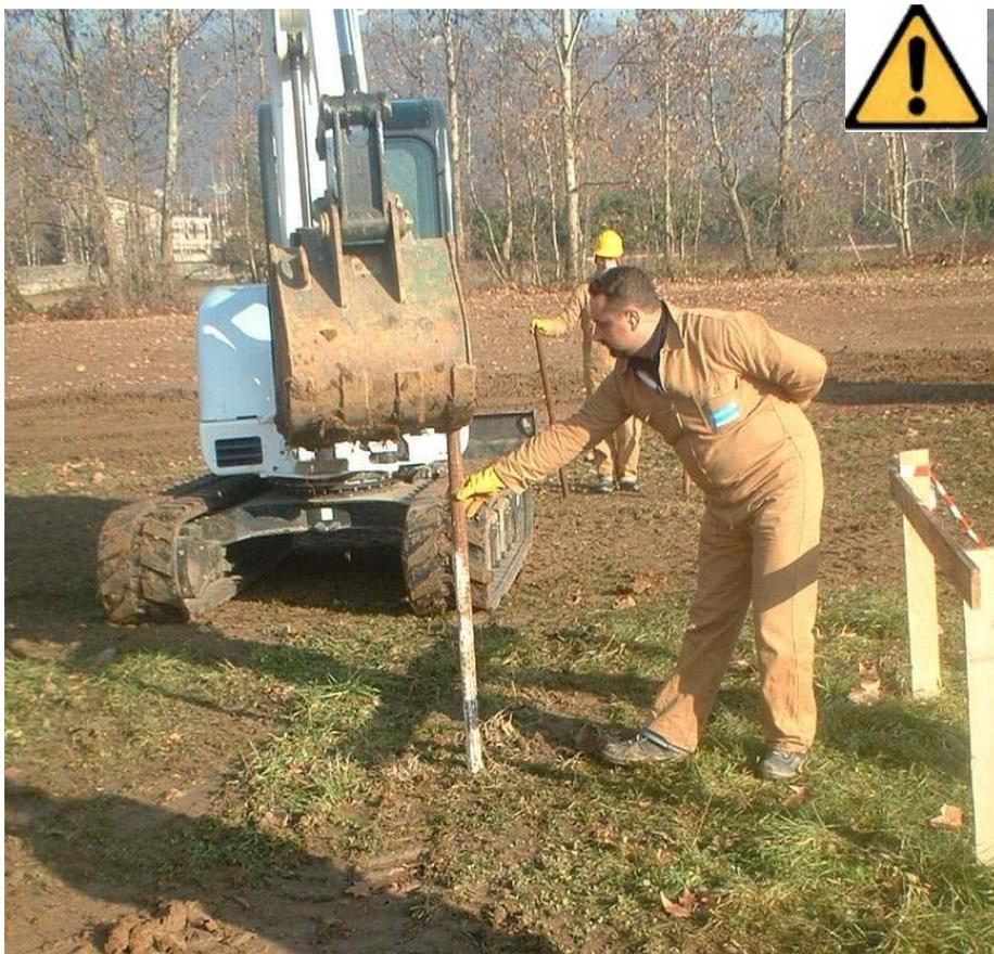
Operazione **assolutamente pericolosa** da non effettuarsi in quanto è elevato il rischio di collisione tra le parti del corpo dell'operaio e la benna della macchina
