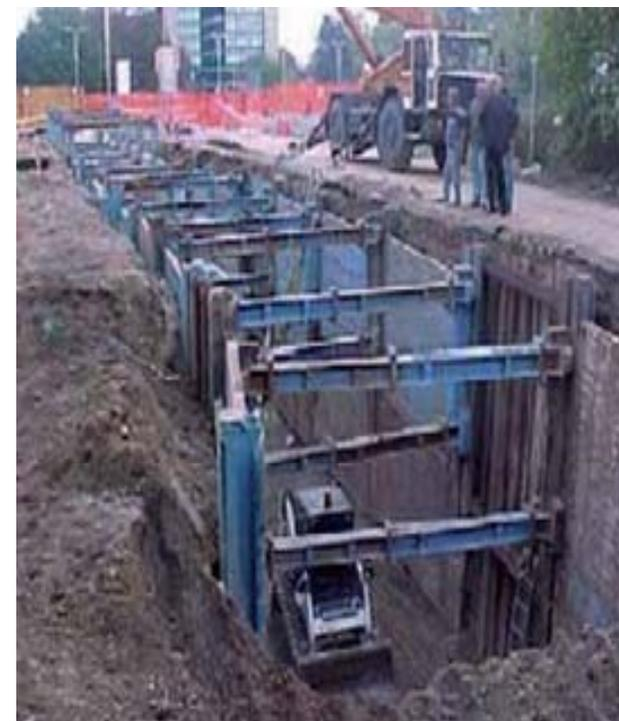
Armature parallele collegate tra loro da aste o martinetti a contrasto regolabili per sostenere le pareti dello scavo
