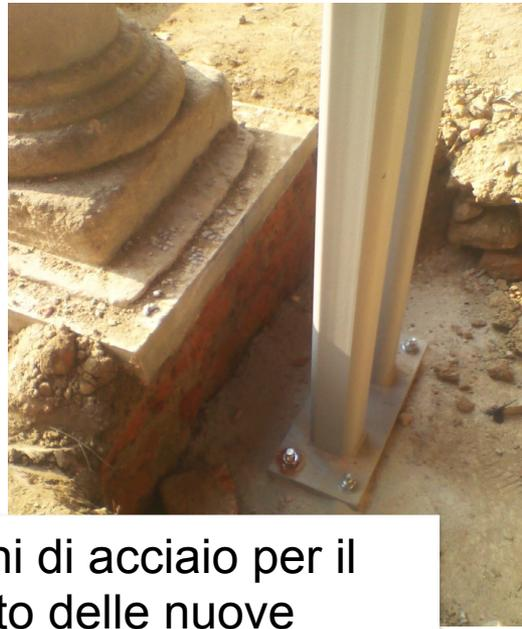
pilastrini di acciaio per il supporto delle nuove strutture metalliche collaboranti
