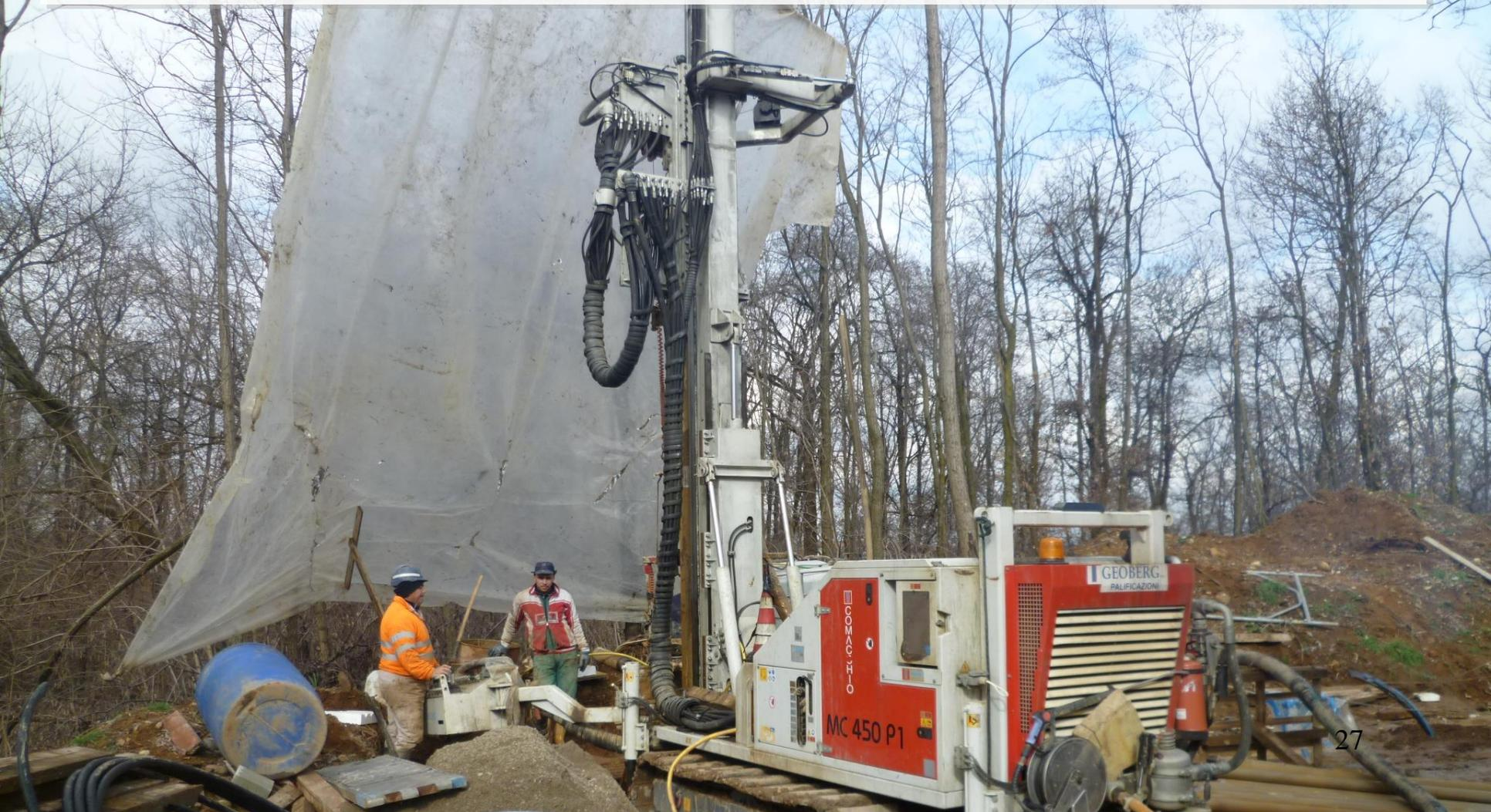
È costituito da n. 8 sonde geotermiche per una profondità di c.ca 90 m cadauna.
