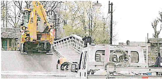
Un'immagine d'archivio di lavori al ponte in chiatte a Bereguardo
