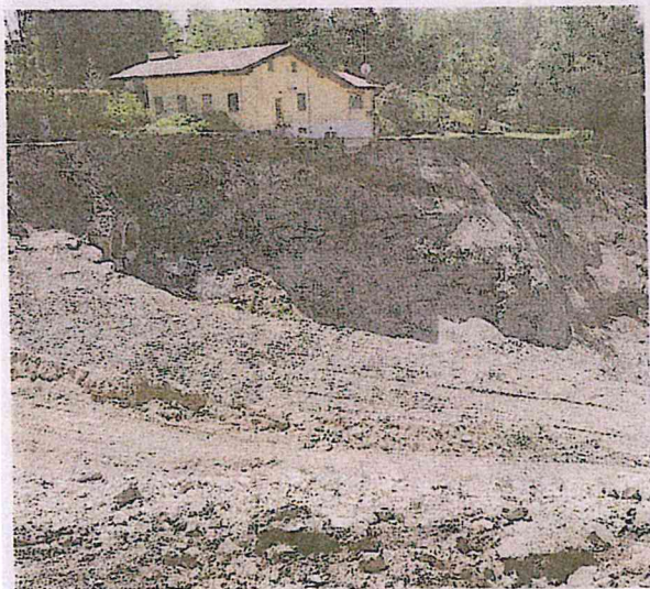
Villa Rovello al bordo della frana prima del crollo nel 2012
