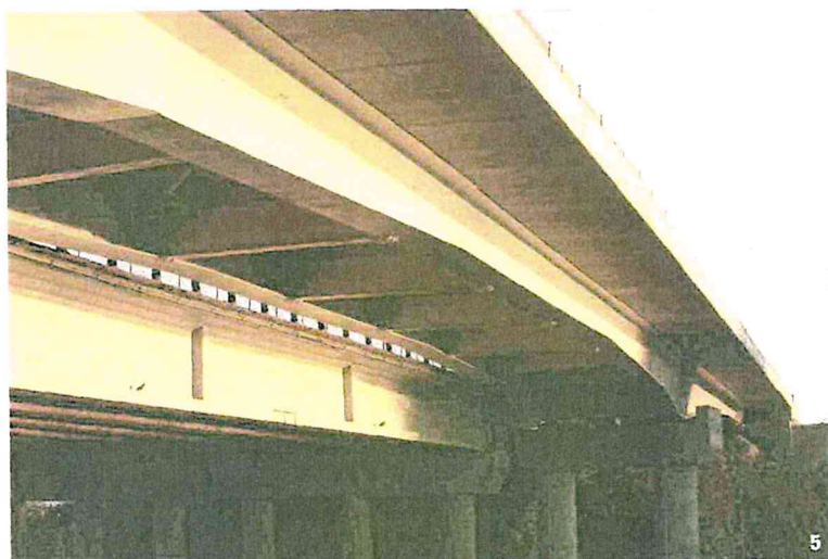
5, 6. I cavalcavia del Veneto sono stati trattati con pittura epossidica e smalto
