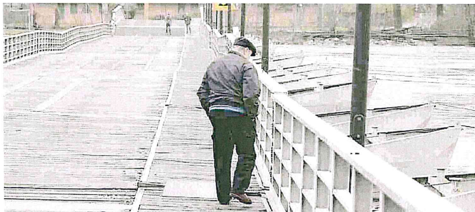
Il ponte in chiatte di Bereguardo: forse la svolta per salvarlo dal prossimo tavolo tecnico
