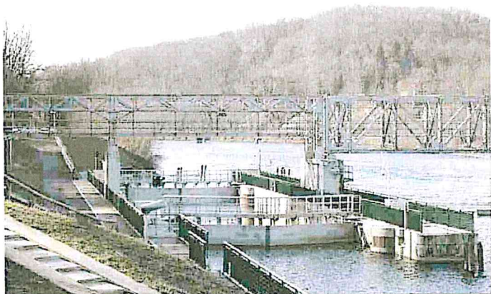
La diga della Miorina regola il livello del lago Maggiore (foto Archivio)
