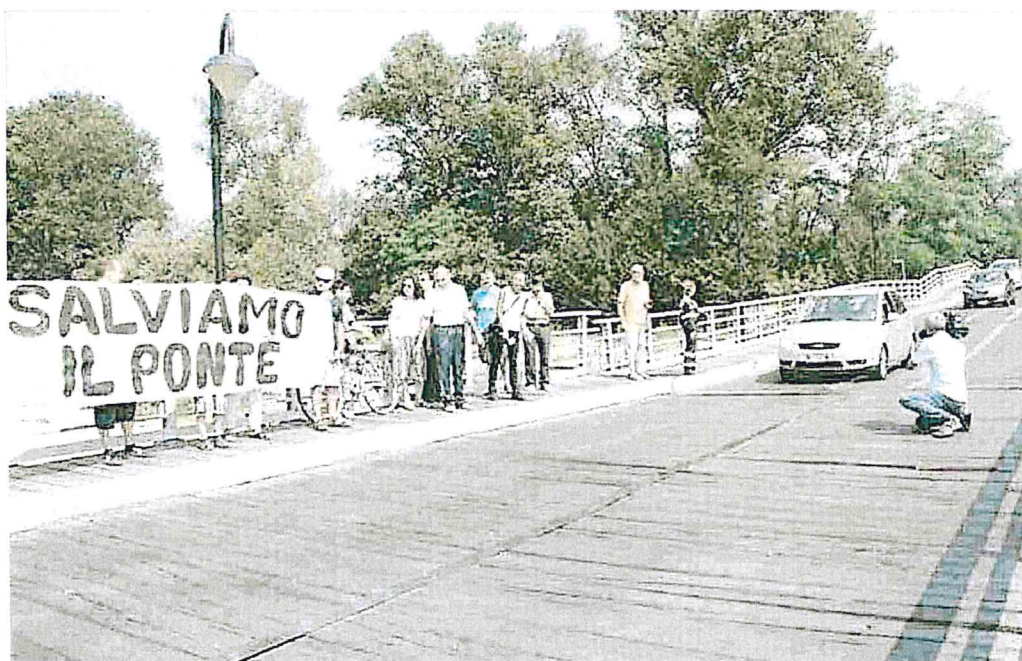
Il Ponte delle Barche di Bereguardo ha urgente bisogno di interventi
