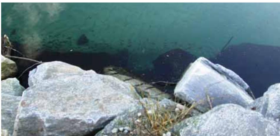
FIG. 6-13 ESEMPIO DI SCOGLIERA REALIZZATA A PROTEZIONE DELLA SPONDA FLUVIALE.
