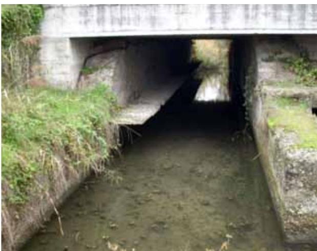
FIG. 6-20 SOTTOPASSO DELL'AUTOSTRADA A7 MILANO-GENOVA E SCHEMA GRAFICO. LA CONTINUITÀ È REALIZZATA MEDIANTE LA CREAZIONE DI UNA MENSOLA LATERALE.
