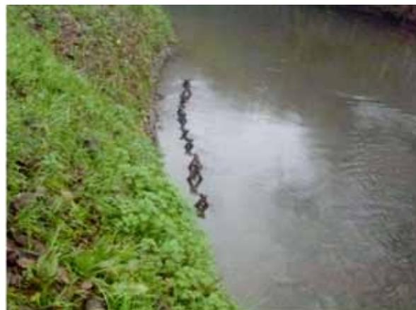
FIG. 8-6: ALTRI INTERVENTI DI DIVERSIFICAZIONE SPONDALE SUL COLATORE GRAVELLONE CON RAMAGLIA – POST OPERAM
