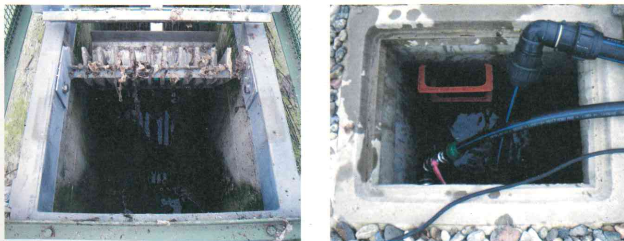
Fig. 4.9. - Punti di campionamento dell'impianto in ingresso (Trade1) e in uscita (Trade2)
