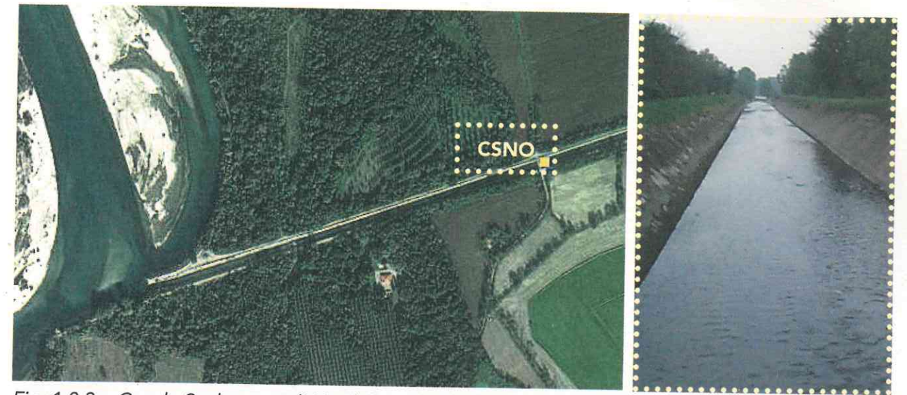
Fig. 1.8.3. - Canale Scolmatore di Nord Ovest - Stazione di campionamento CSNO
