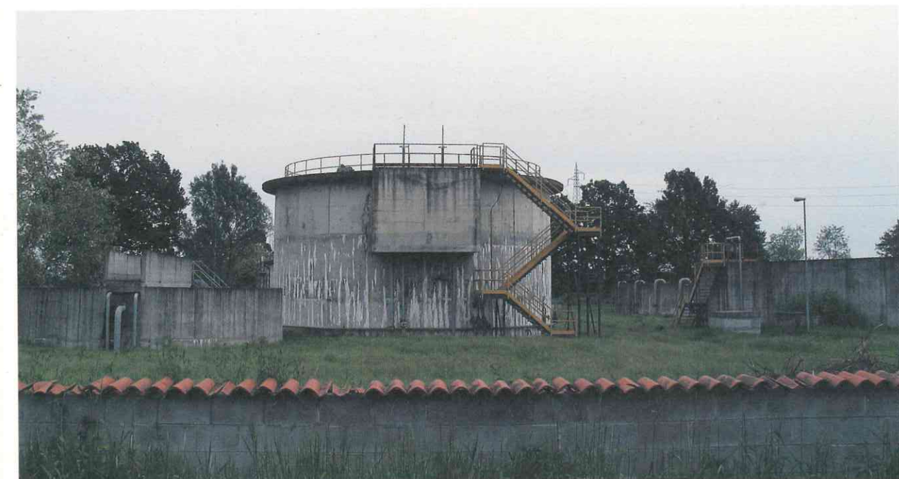
Fig. 1.14.3. - Depuratore di Garlasco
