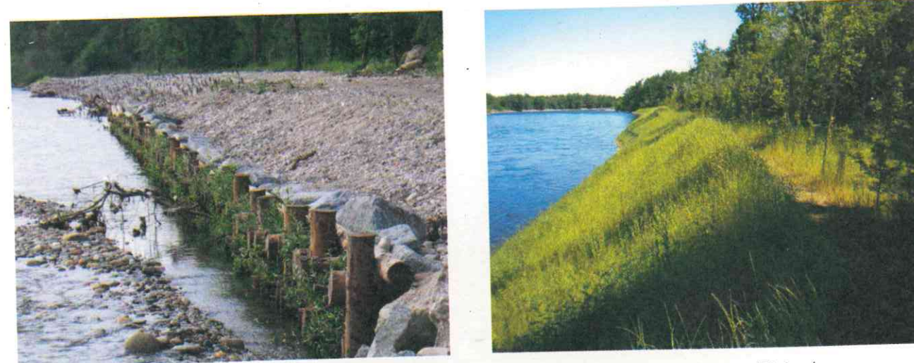
Fig. 2.3.1. - Difesa spondale (Trecate) e difesa in fase di riambientazione (Marano Ticino)
