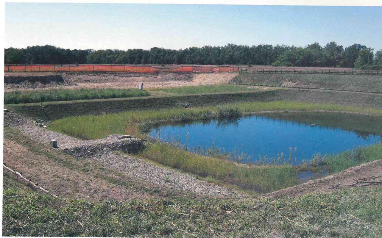
Fig. 4.7. - Particolare dei bacini di fitodepurazione dell'impianto di Vizzola Ticino - Trade Center
