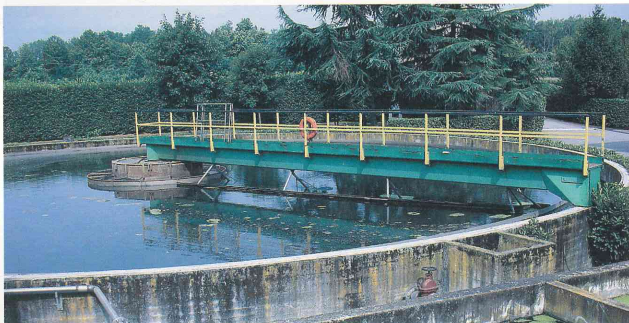
Fig. 1.9.1. - Depuratore di Turbigo
