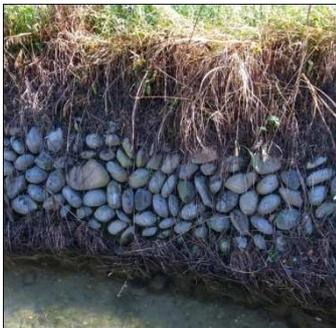
Muro a secco di contenimento. E' da notare la disposizione ravvicinata dei ciottoli e il tentativo di disporre in file orizzontali sovrapposte.
