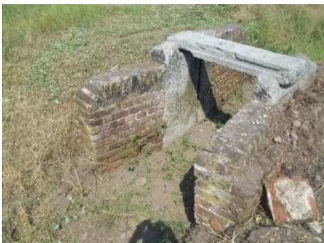
Manufatti irrigui in mattoni e granito consolidati o completati dove necessario con materiale di recupero.
