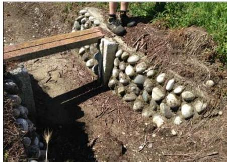
A sinistra manufatto irriguo e a destra muro di contenimento, entrambi di nuova costruzione in ciottoli legati con cemento. Pur riconoscendo la disposizione orizzontale, sarebbe preferibile avvicinare di più i ciottoli e le file orizzontali fra di loro, lasciando le fughe sottili e rientranti, usando sabbia o malta di calce idraulica.
