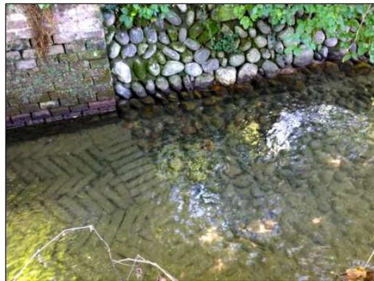
Manufatti irrigui in cui viene accostato l'uso dei mattoni e dei ciottoli (sia per il fondo sia per le spallette e il muro di contenimento).
