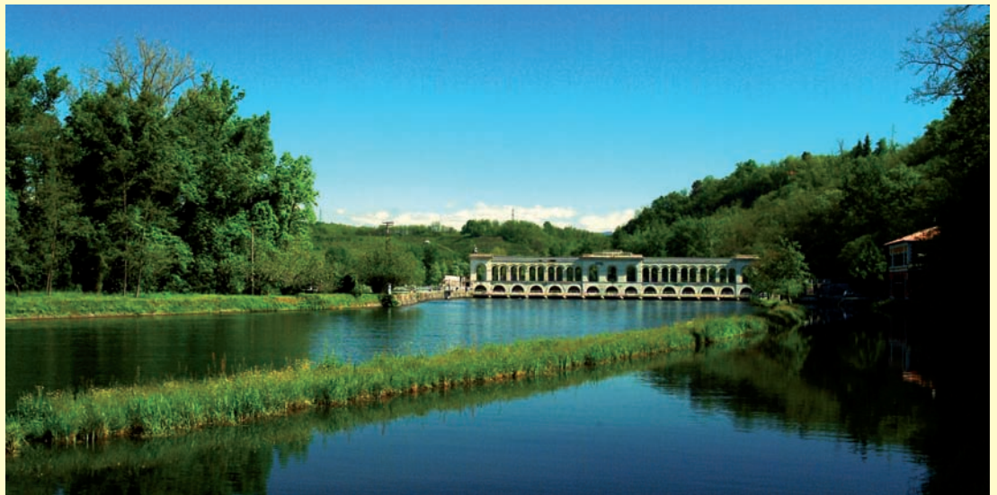
Figura 4.7: Produzione di energia elettrica da fonti rinnovabili: il Parco del Ticino punta sull'acqua. La diga del Pan-perduto - presa del Canale Villorresi (Va)
