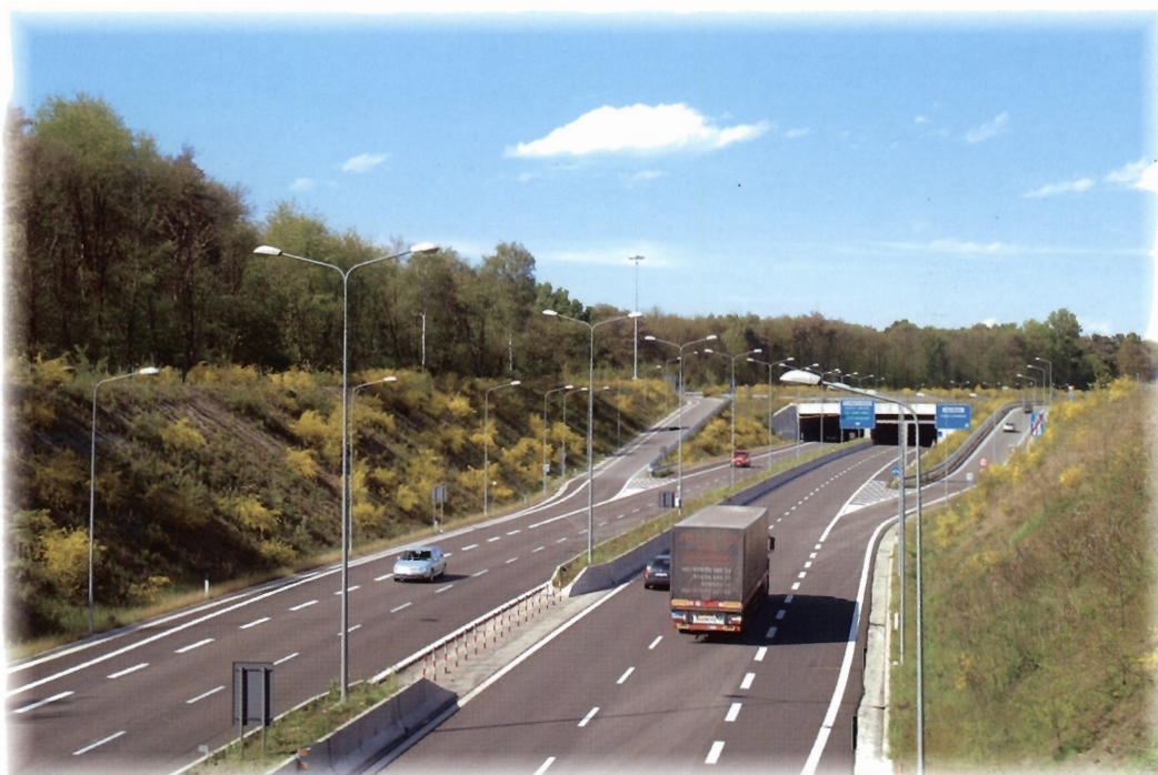
Figura A1. Tratto di Strada Statale S.S.336
