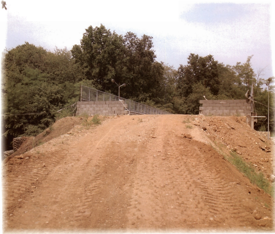
Figura A7. "Ponte verde" in fase di realizzazione
