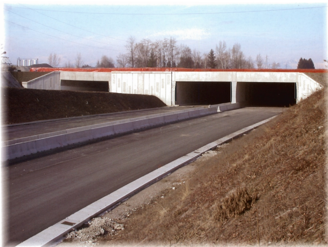
Figura A4. Galleria artificiale sottostante il "ponte verde"
