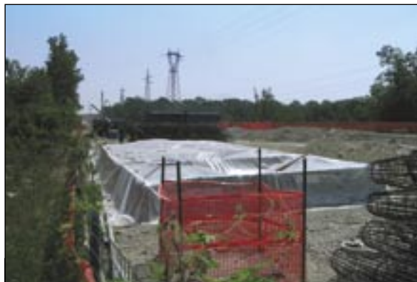
L'erosione di habitat naturale nelle aree di sosta, dovuta alla realizzazione di nuove aree urbane o infrastrutture, è uno dei principali fattori di minaccia per la persistenza delle popolazioni migratrici. Il Parco del Ticino ha subito in modo particolare tale fenomeno, soprattutto nell'ultimo decennio, con la realizzazione o l'espansione di numerose infrastrutture quali treno ad alta velocità, superstrade ed aeroporto (Foto di P. Bonazzi).
