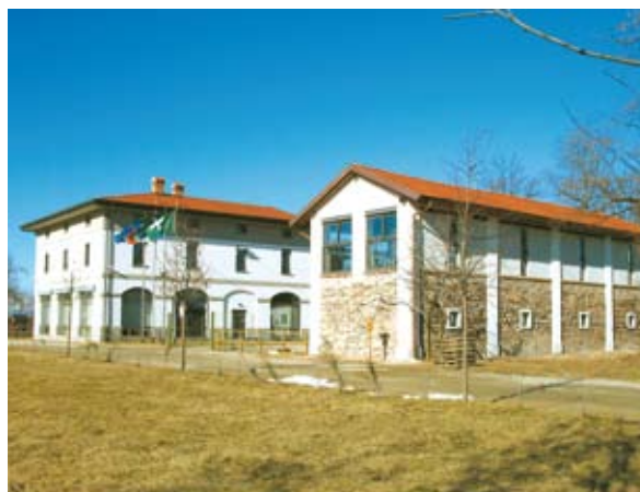
Centro Parco "Dogana Austroungarica" a Tornavento di Lonate Pozzolo (VA)
