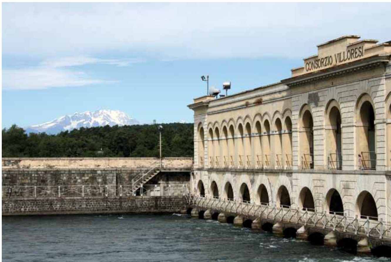
Figura 2 – La diga del Panperduto (Foto Fabio Casale).
