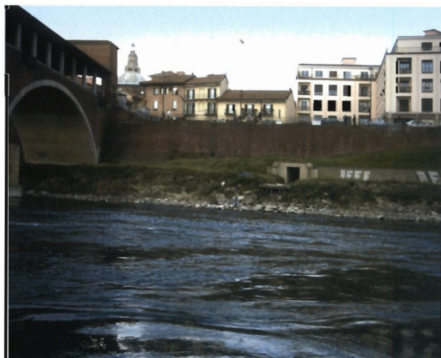
Scarico di un troppo pieno nel comune di Pavia
