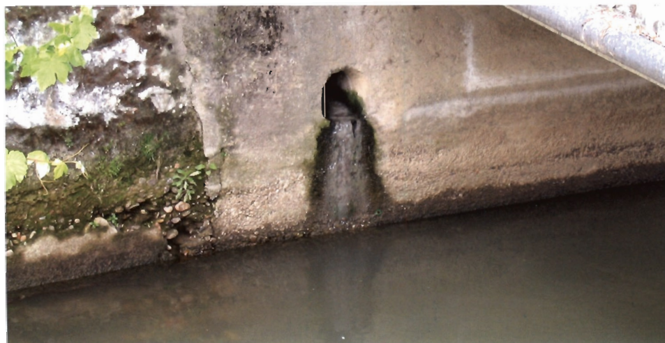
Scarico in un ramo della roggia Cerana
