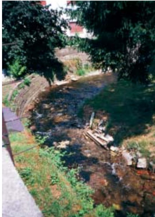
In evidenza l'artificialità della sezione trasversale e la presenza di difese spondali (15-6-2001).
