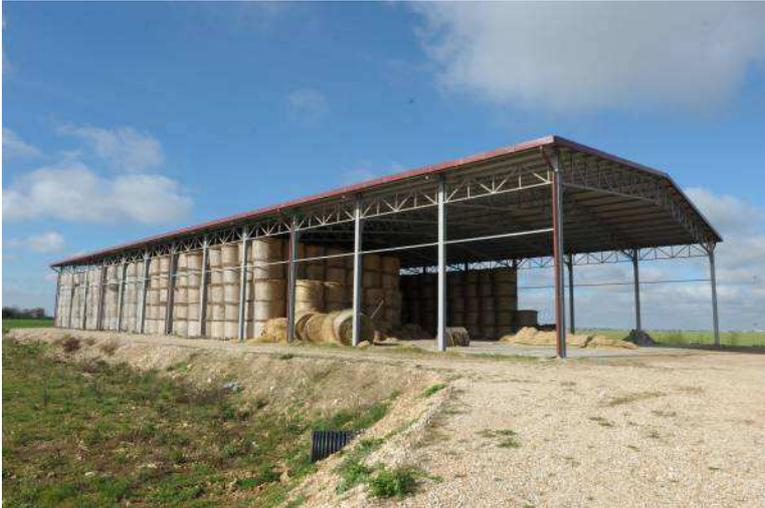
*I fabbricati destinati allo stoccaggio del foraggio fienato, sono di forma e struttura variabile, spesso con rilevante componente prefabbricata. Possono essere realizzati in calcestruzzo armato, acciaio e/o legno, con o senza tamponamenti.*
