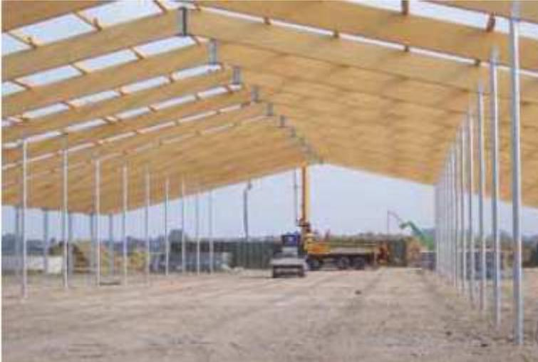
*I sistemi costruttivi più comuni prevedono: travi e pilastri, con impiego di materiali prefabbricati di acciaio, legno o calcestruzzo armato.*
