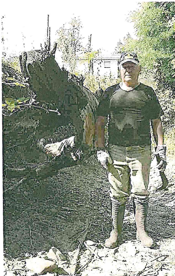
Gli operatori della Protezione civile hanno trovato anche dei ceppi d'albero nell'alveo del Sorgiorile
