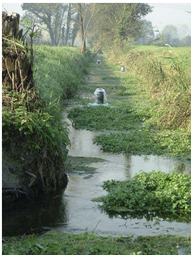
Fontanile perenne di forma lineare (fontanile Quattro Ponti a Liscate, MI); gli occhi del fontanile, costituiti tradizionalmente da tini di legno, oggi sono stati sostituiti con tubi in ferro
