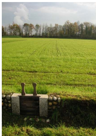
Nuovo manufatto irriguo, nel rispetto della tradizione
